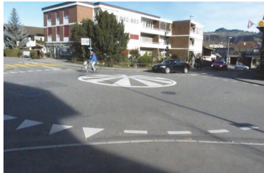
Ungebremste Durchfahrt bei sogenannten Minikreiseln (Freie Strasse – Schulstrasse – Schorenstrasse)
