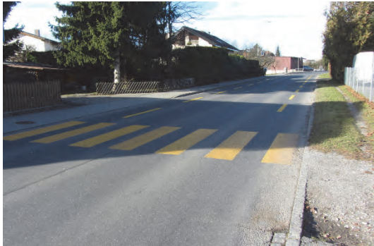
Fehlender Fussweg und mangelhafter Fussgängerübergang auf Pfanderstrasse
