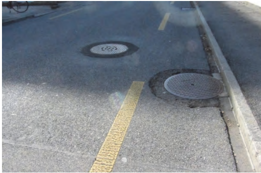
Schorenstrasse: Einlaufschächte auf dem schmalen Velostreifen
