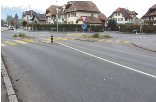
Bypass beim Kreisell Jungfraustrasse – Pestalozzistrasse, ein für den Veloverkehr gefährlicher Kreisell im Umfeld von Schulen
