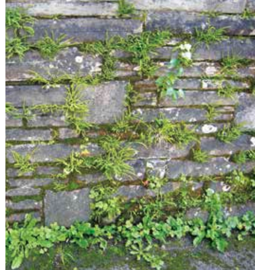
Trockenmauer, Schattenseite
