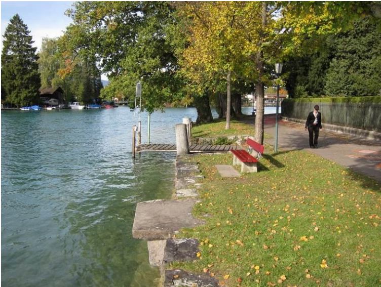
Bestehende Anlegestelle Seite Bächimatte
