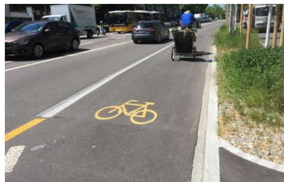
Die höhenversetzte Anordnung des Velobereichs separiert den Veloverkehr wirksam und ist platzsparend.
