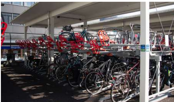
Beispiel Doppelparker (Typ Orion 5R+TOP, Achsabstand 50 cm) in der Velostation Thun.
