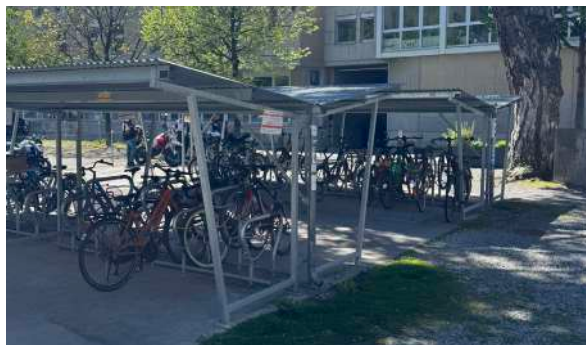
Beispiel einer Langzeit-Abstellanlage an der Aarefeldstrasse in Thun (Typ Beta XXL, Achsabstand 45 cm).
