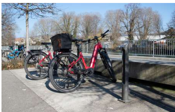
Abstellanlage Scheibenstrasse Ost, Thun. Anlehnpfosten mit Anschliessmöglichkeit flexibel und selbstaufrichtend (Typ Babyk Pro mit Formgedächtnis, Achsabstand 1.3 m).
